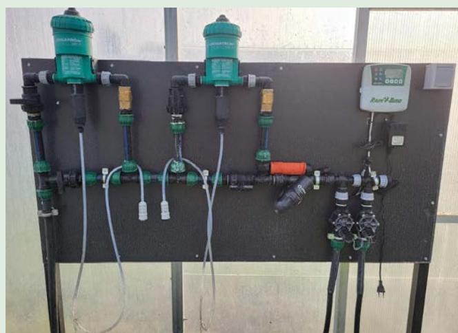
Fot. 3. Zestaw dozowników proporcjonalnych z elektrozaworami i sterownikiem
